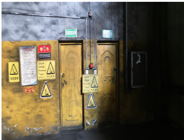
危废暂存间及一般固废暂存间
