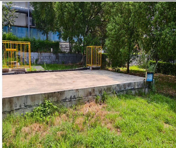
初期雨水收集池
