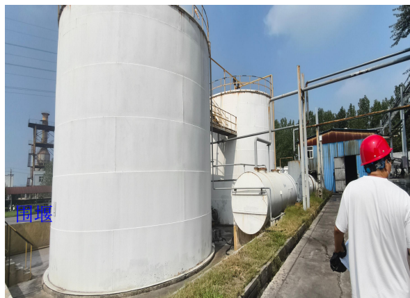
厂区现有罐区
